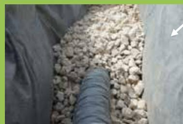
Une géomembrane assurera l'étanchéité pour éviter toute infiltration d'eau
